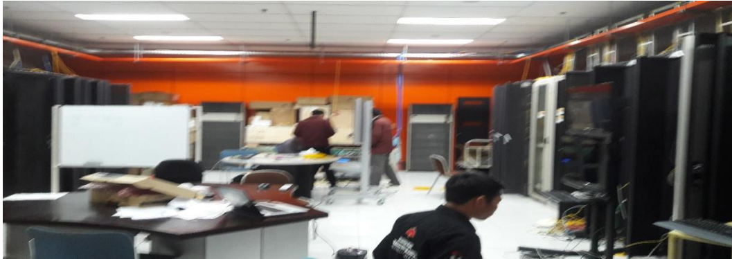
Gambar 2.2 Ruangan Penempatan Kerja
