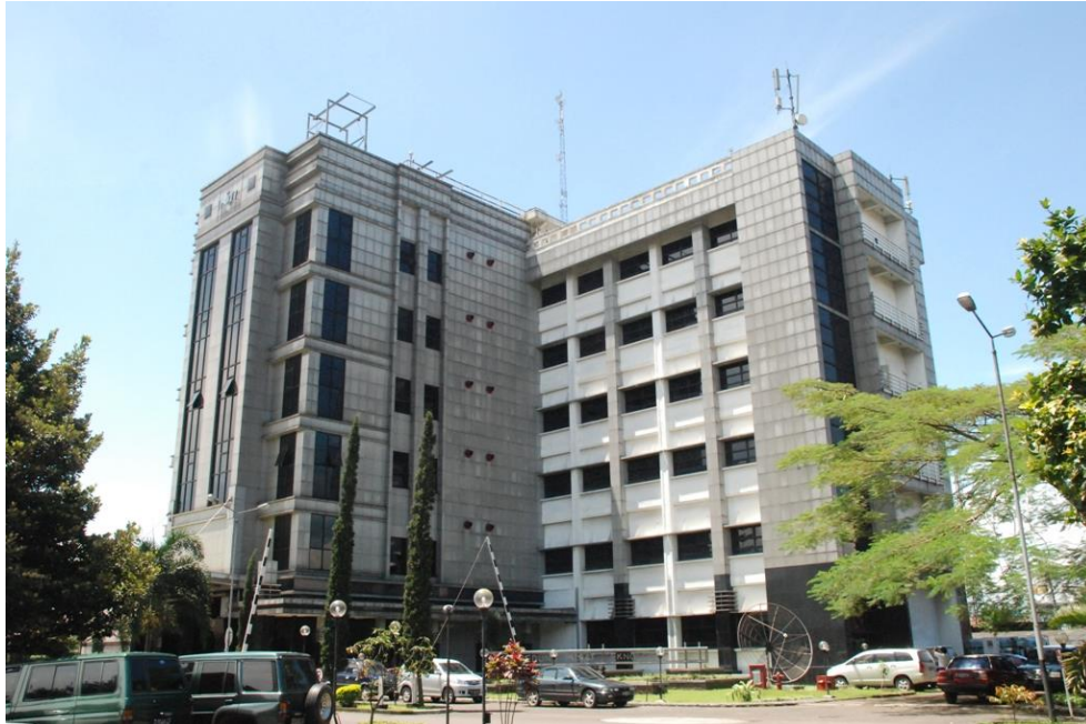
Gambar 2.3.1 Gedung PT INTI
