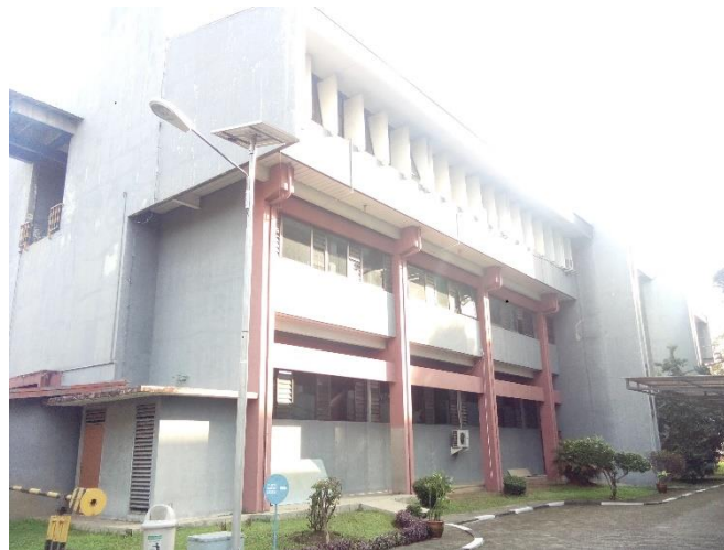
Gambar 2. 3 Gedung lokasi KP
