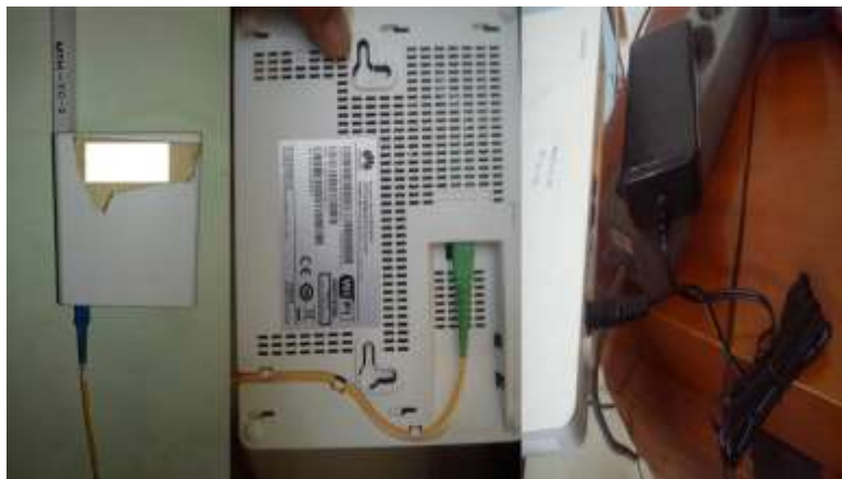
Gambar 3.16 Instalasi ONT pada Roset
