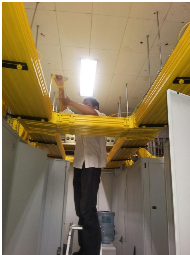
Gambar 14 Penyambungan ulang patchcord FTM
